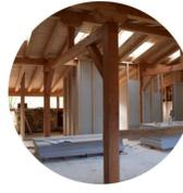
Tabiquería interior ecológica de **YESO Y CELULOSA** reciclada sobre estructura de **MADERA**
