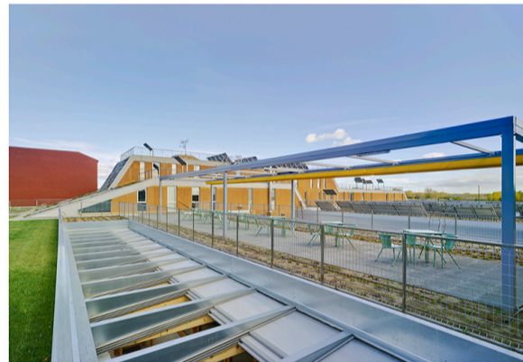
Cubierta con invernadero
