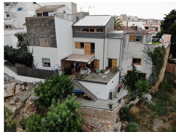
Vista fachada trasera
