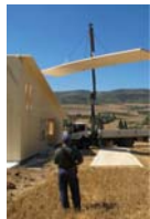
La prefabricación permite montar totalmente el volumen de la casa en 3 días.
