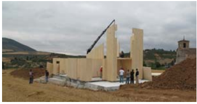
Una autogrúa y tres operarios son suficientes para el montaje de los paneles que conforman la edificación.
