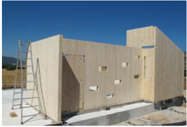
La estructura vertical, el forjado y la cubierta son prefabricados de madera maciza contralaminada.
