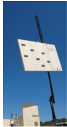
La estructura vertical, el forjado y la cubierta son prefabricados de madera maciza contralaminada.
